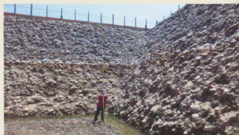
Fig.18 礫層の色が異なり、下位から水が湧きだしている様子
