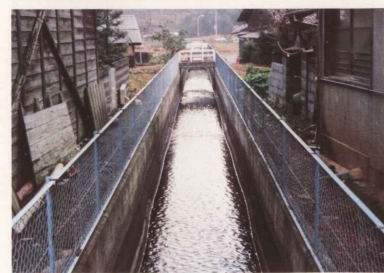
西部幹線水路
