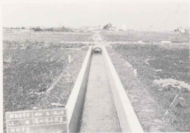
団体営長森用水路（岐阜市前一色地内）
