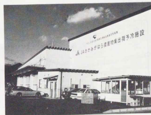
集出荷予冷施設
