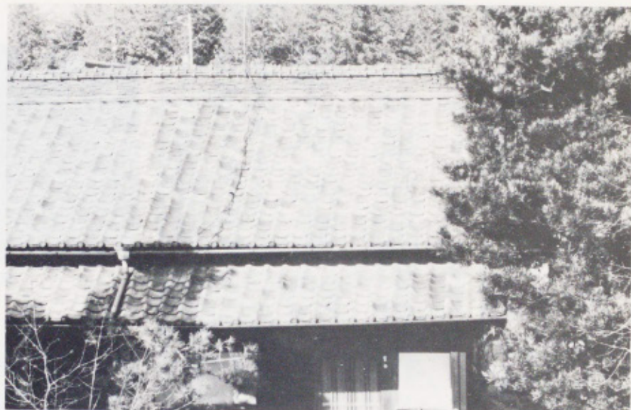
敬恪義校の屋根の棟 (大人の腰までの高さ)
