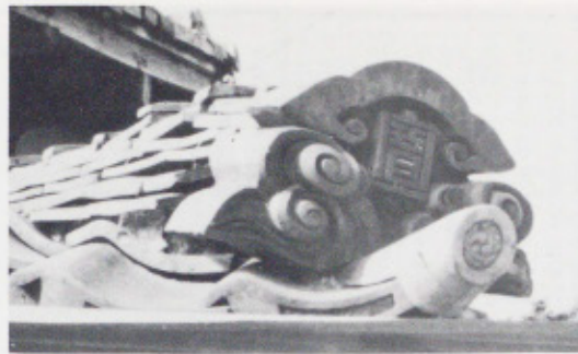
小佐野小学校の屋根瓦（現在）
