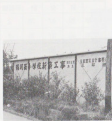
敷地 (稲羽西小学校用地)
