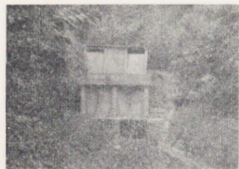
関市小瀬高井坪山前 現調節水門
