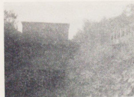
関市小屋名 現旧取入口
