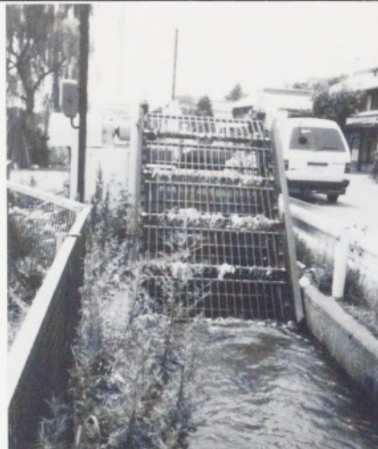
●ごみ取り機とフェンス
