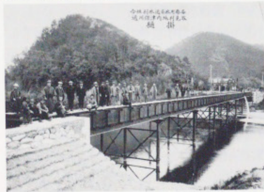
● 鋼製掛樋の完成
