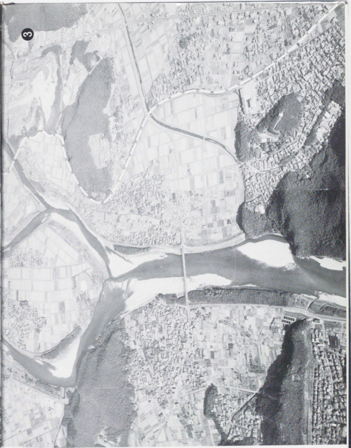
■各務用水の航空写真 関市下白金、岐阜市芥見地内 津保川サイホン——開渠部
