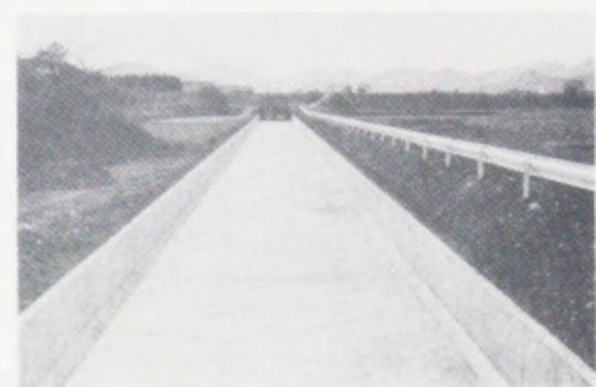
● コンクリート水路にする工事
