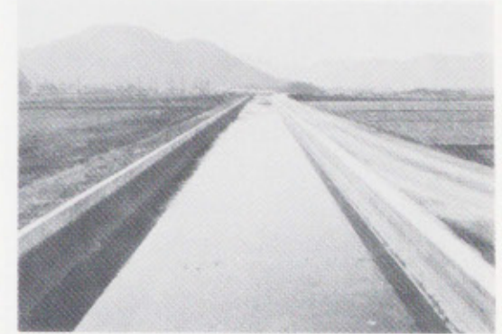
● 幹線水路の改良
