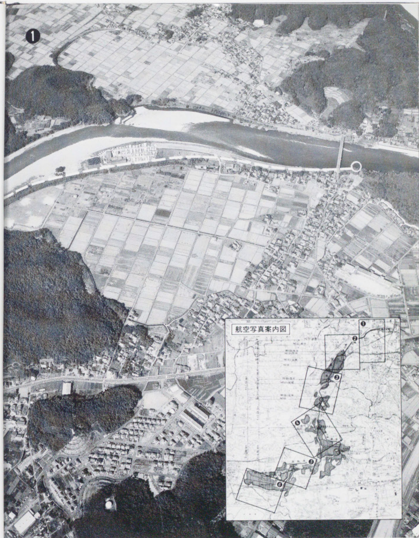
■各務用水の航空写真 関市小瀬地内 長良川取水口—導水トンネル
