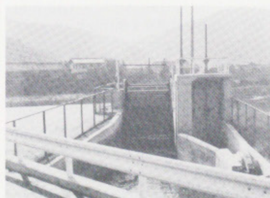
●発電取水口を計画したところ
