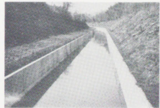
● 水路施設の整備、補修
