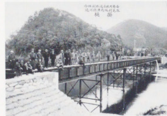
● 掛樋竣工 (芥見)
