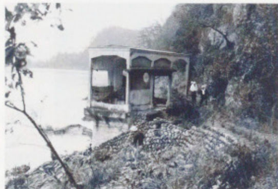
● 取入水門の被害状況
