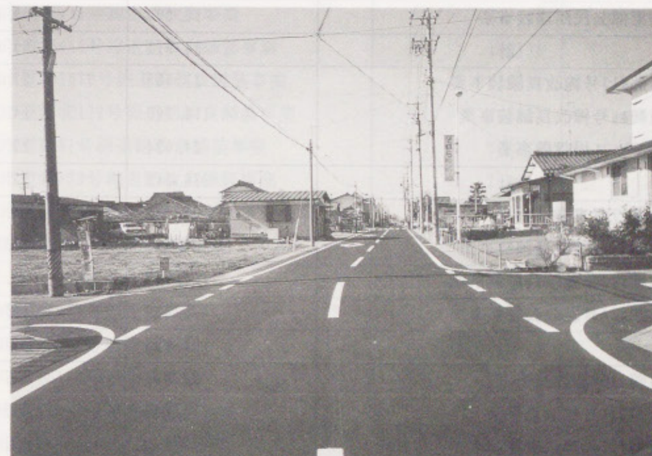
蘇南25号線改良舗装事業
