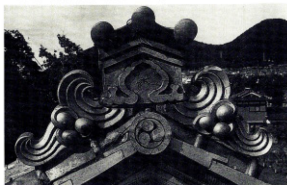
写16 赤坂神社拝殿 屋根瓦
