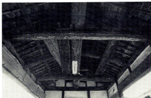
写15 赤坂神社拝殿 内部小屋組
