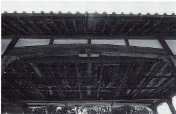
写57 天神神社拝殿 背面より内部小屋組を望む
