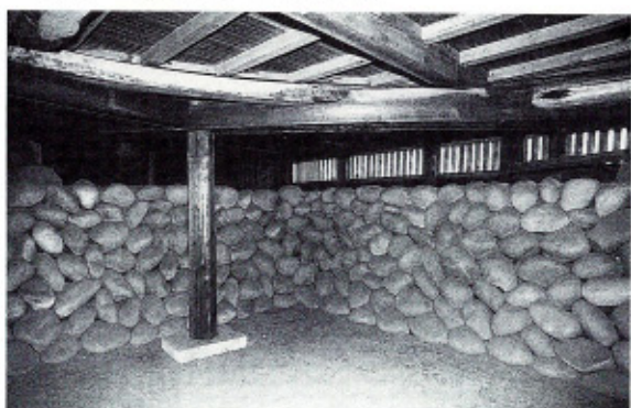
写28 【皆楽座】奈落石垣
