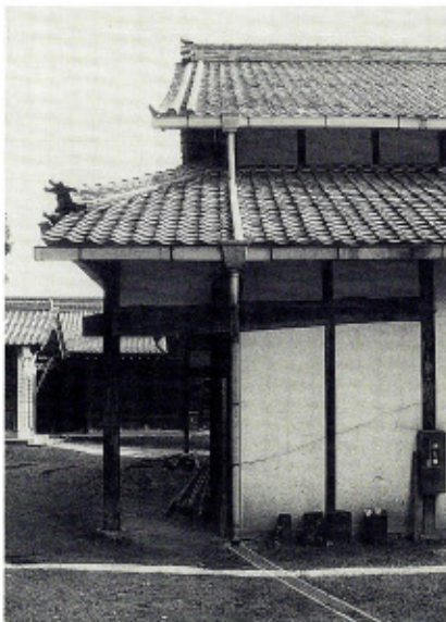
写37 【村国座】側面（西北部）
