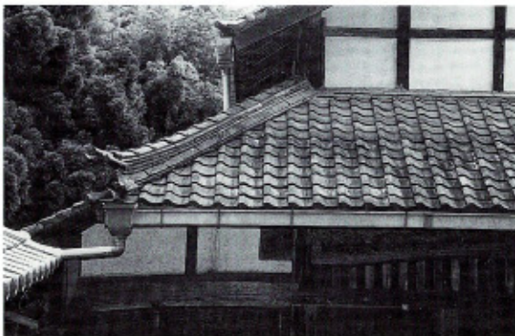
写43 【村国座】大屋根と前庇と下屋
