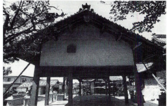
写54 天神神社拝殿 側面(東面)
