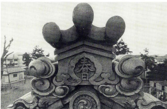
写64 春日神社拜殿 屋根瓦
