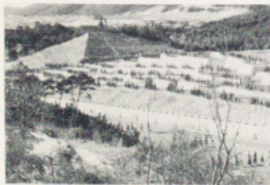
進む宅地造成
