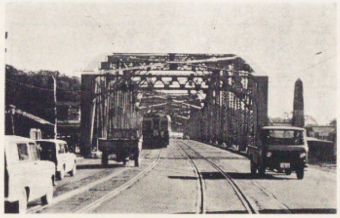
国道41号線の様子
