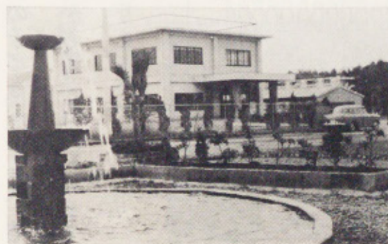
金属団地事務所
