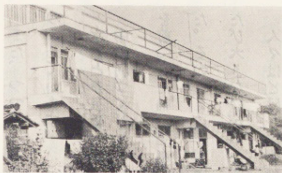
水害のあとできた鉄筋住宅
