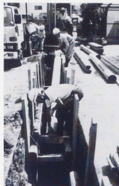
↑直径25cmの下水管をうめているところ。家庭から出る下水はこの管に集められていく。
