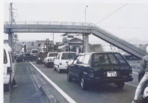
歩道橋（渡道橋）
