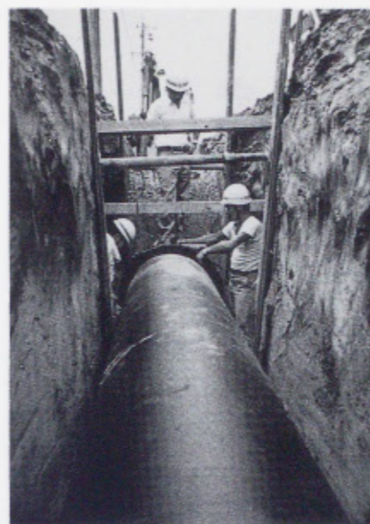
水道しせつの工事
