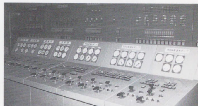
コントロール室のコンピューター
