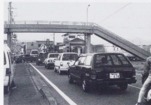
歩道橋（渡道橋）
