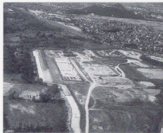
↑岐阜県各務原浄化センター この浄化センターには、四つの市と九つの町から下水が集められます。ここでは、下水がいくつもの池や消どくせつびを通ることによって、しだいにきれいな水にかえられていきます。
