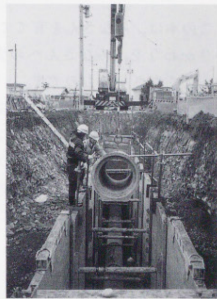
↑直径90cmの下水管をうめているところ、地区ごとに集められた下水が流される。
