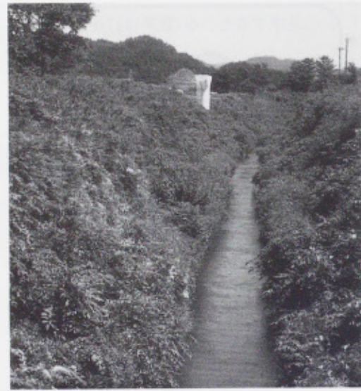
② 掘り下げられた低いところを通る水路(小瀬)
