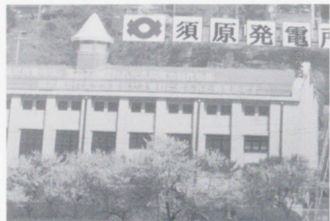
須原発電所の全景
