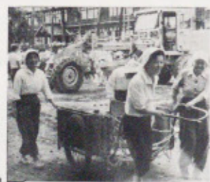
P.T.A.による校庭整地作業（昭和35年）
