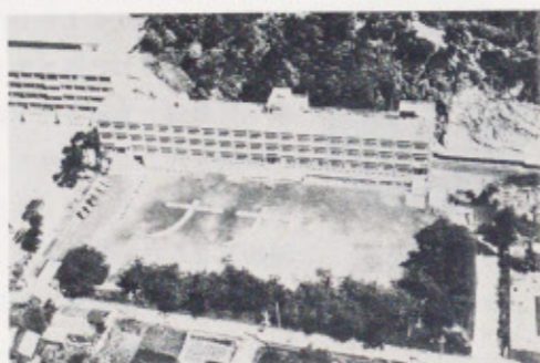
第3舎撤去後の学校
