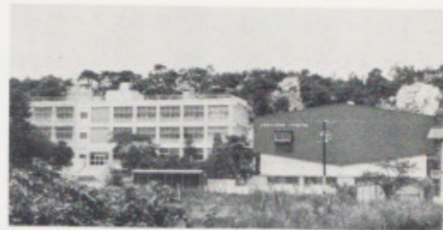
第3期工事完成後の校舎と体育館
