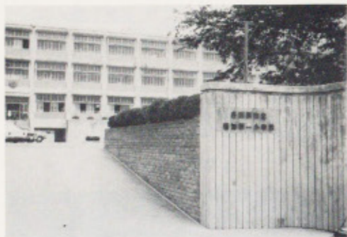
校門と本館（第2期工事分）
