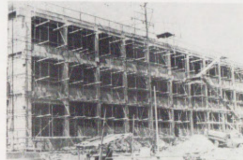
建築中の鉄筋校舎
