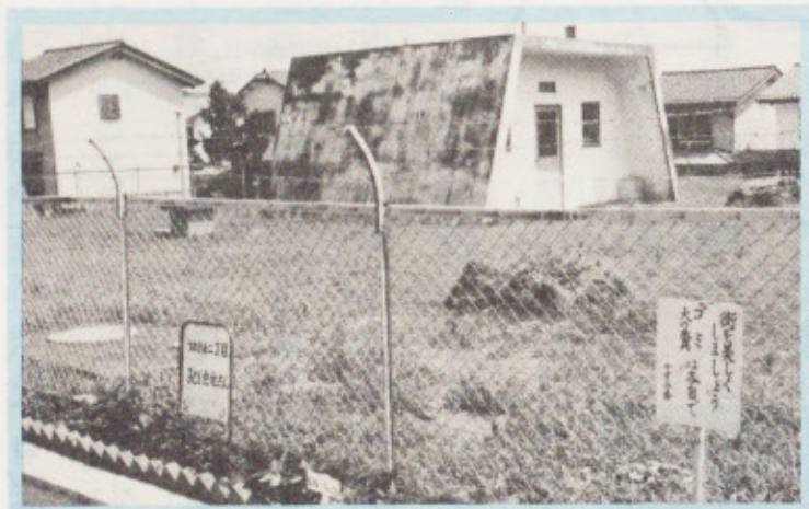
鶉沼東部（小林低区）配水池
