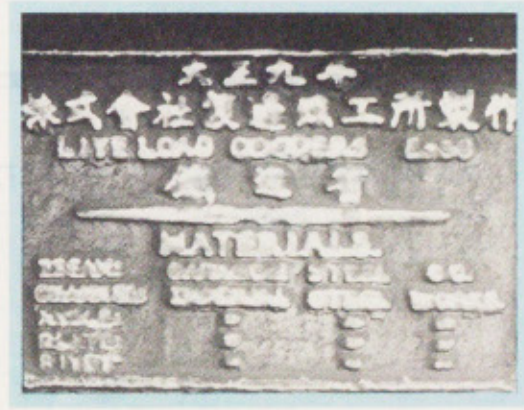
天神川鉄橋についているプレート（大正9年）
