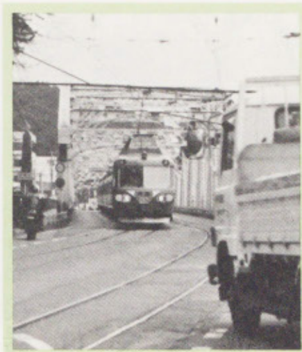
混雑する犬山橋
